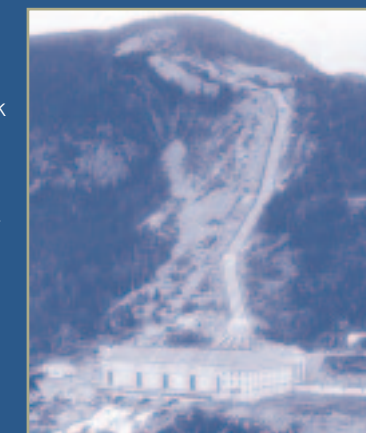
De "gammeldagse" kraftverkene, med rørgate i fjellsiden og stasjonsbygning ute i dagen, var arkitektoniske perler. (Foto fra Nore.)
