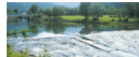
Bygging av terskler i elveløp gir vannspeil som er av verdi for både folk og livet i vannet.
